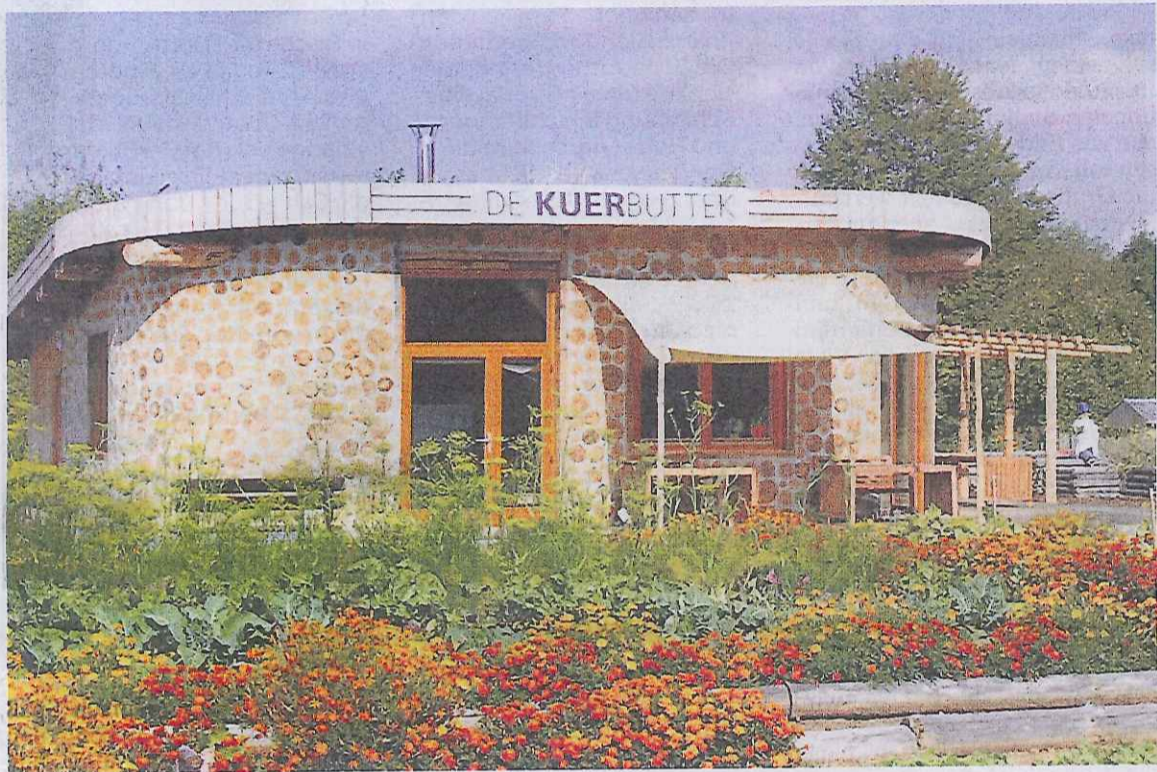
L’épicerie solidaire de Pétange réalisée en partenariat par le CIGL local
